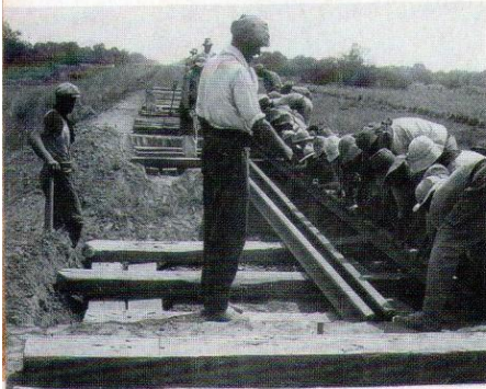
Construcción de una vía férrea, a principios del siglo XX.
