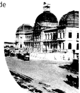
[FIG. 272] Construcción del Palacio de Justicia de La Plata en 1885, al año siguiente de su fundación.
